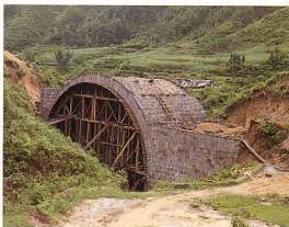
2. 玄武岩質溶岩が建築用石材や道路の敷石に活用されている。硫黄塘付近で見かけた建設中の石橋。
