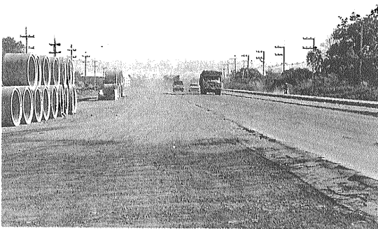
写真3 拡幅が進む国道4号線。2車線から4車線へと着々と工事が進められている。サラ・プリの東郊外で。
