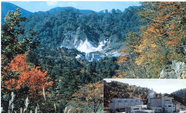
鬼首地熱発電所を東方から望む写真(上：背景は片山地獄)と地熱発電所全景(右)
