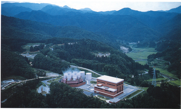
柳津西山地熱発電所を北東方から望む写真
