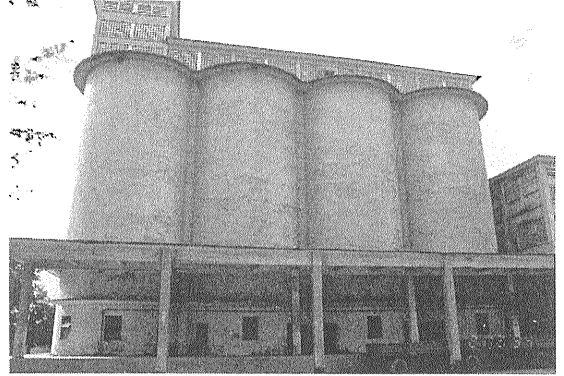
第11図 カンポート市郊外のセメント工場。年間10万tのセメントを生産しているという。
