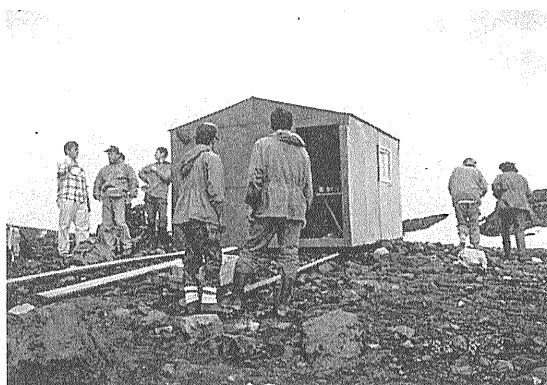
写真3 火口湖を見下ろす旧火口内に設置された鉄製観測小屋。ヘリコプターで持ち運ぶ。内部にストーブを備えている。最大5人が寝泊まりできる。風雨に強いが、気温が下がると辛い。
