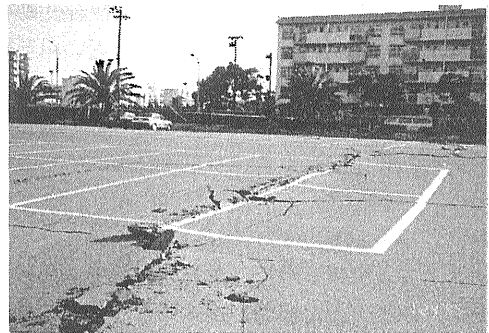
写真1 音波探査で認められた断層の延長上に認められる横ずれ変形を伴う地割れ(神戸市須磨マリーナ)。
