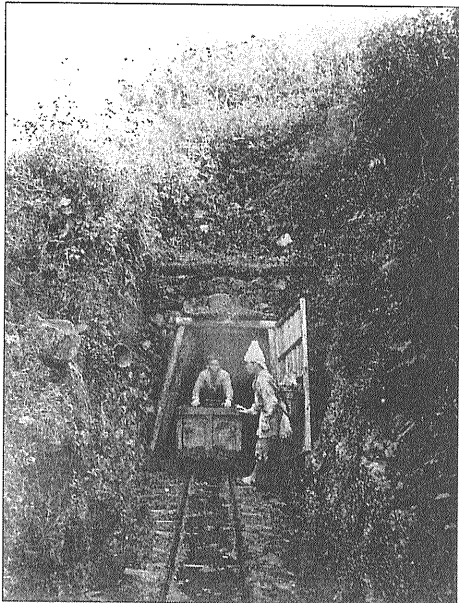
写真4 山ヶ野晒鉱口。明治30年頃のアルバムから。晒坑は主要坑口の一つ。鉱石は手押しの特ロッコで製煉所に運ばれた。右側の坑夫は、ダッテゴという竹製の籠を担い、藁で編んだシリアテを腰に巻いている。
