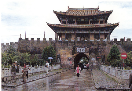
1.大理の城門。煉瓦を積み上げた城壁に、大理の文字を彫り込んだ石灰岩の板がはめ込まれている。手前の歩道の欄も石灰岩。
