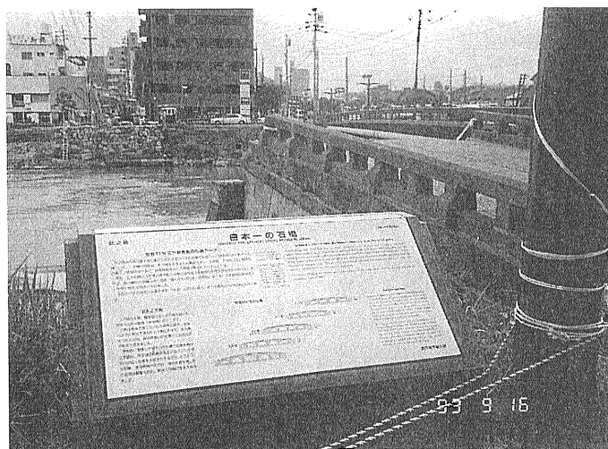
写真1 流出した武之橋。 左岸側のアーチ一つを残し流出している。
