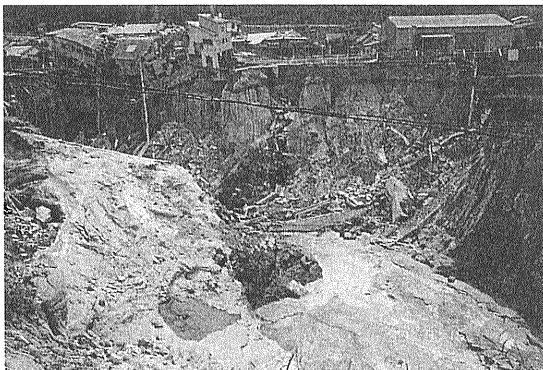
写真5 左岸側から見た陥没現場。左端の基盤の高まりに旧河道がある。基盤には入戸火砕流で焼かれた炭化木が見える(鹿児島市小山田町名越)。
