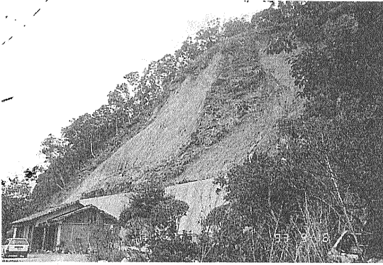
写真2 鹿児島市玉里町の小規模な崖崩れ現場。 ごく表層のみ崩れている。この程度の崩壊はあちこちに見られる。
