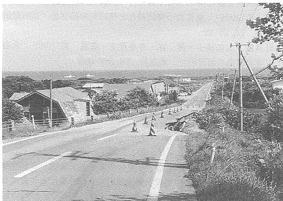
写真7 段丘崖を盛土した部分のみ道路に亀裂が入っている(奥尻町米岡)。
