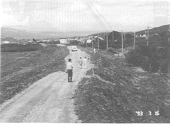
写真2 北檜山町後志利別川河川堤防の不等沈下
