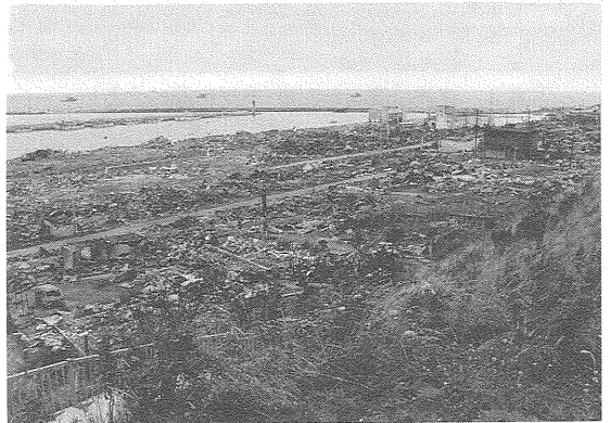
写真5 奥尻島青苗地区を襲った津波とその後の火災により、完新世段丘(上位面, 下位面)にあったほとんどの家屋が消失した。
