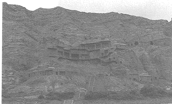
写真9 写真の奥へ緩傾斜する砂岩層に穿たれ、コンクリートにより保全対策の施されたキシル千仏洞
