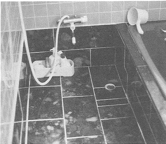
写真2 風間鉱業所1階浴室。見立礫岩がタイルとして使用されている。
