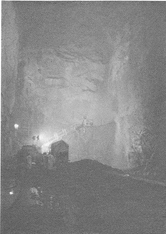
写真11 空洞壁面の油分の除去作業。砂を混ぜた高圧水を吹き付けて落としている。
