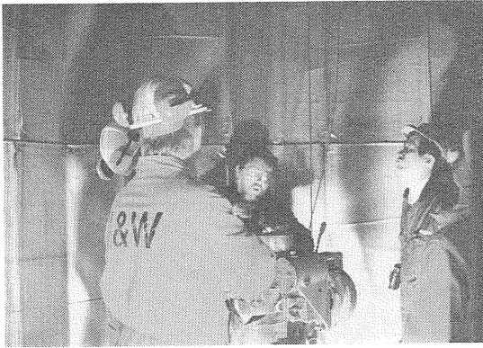
写真9 空洞内部のステンレスライニングの様子
