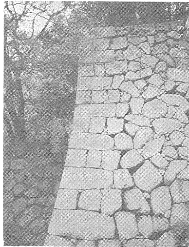
写真10 愛媛県松山城 の石垣。算木 積の角が3本 の石垣で組ま れており、手 間のかかった いわゆる格が 高い石垣。花 崗岩。
