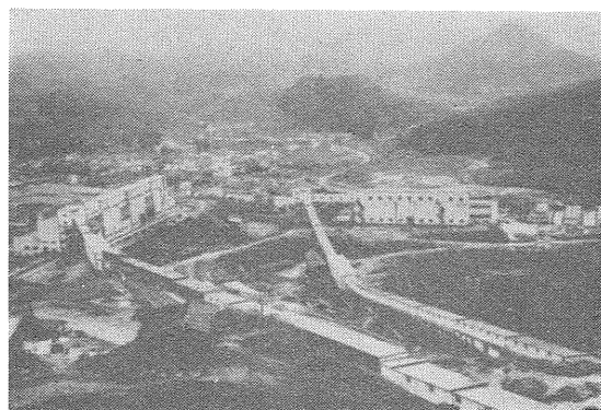
第81図 中国最大の硫化鉄鉱生産基地—広東省雲浮硫化鉄鉄鉱山。右の大きな建物は鉄石破砕工場、左の大きな建物は選鉄所。
