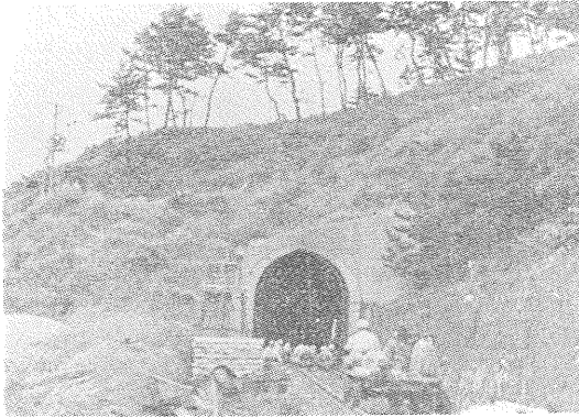
写真6 羽越線鼠ヶ関—小岩川間，赤坂トンネル坑口と地すべり地形（文献2）
