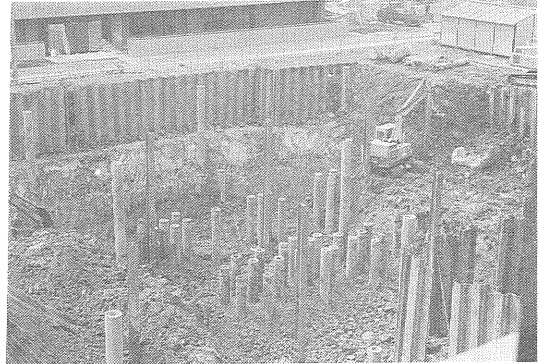
写真6 地質標本館の建設工事がいよいよ始まり、掘削工事から杭打ち工事へと進む。(昭和54年3月19日現在)
