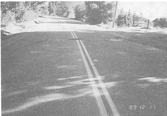
写真3 震源に近い Summit Road の地割れ。1989年12月11日撮影。センターラインが10cm以上ずれている。写真の向こう側が南東方向である。地割れの方法はほぼ南北の横ずれである。このあたり地割れの多くはほぼサンアンドレアス断層に平行の北西—南東方向で、左横ずれと右横ずれが卓越している (Plafker and Galloway (eds.), 1989)。
