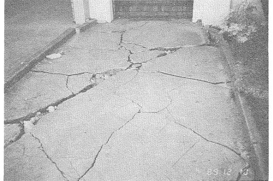
写真2 マリーナ地区の、ある高級住宅の玄関先。1989年12月10日に撮影。地割れと液状化現象でコンクリートの歩道が破壊されている。
