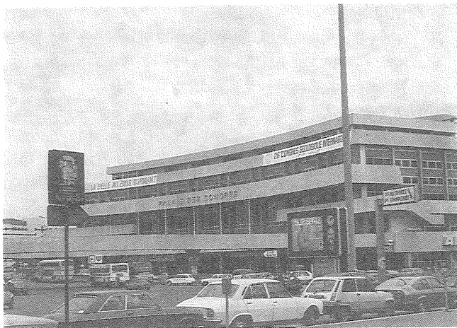
写真2 国際会議場正面玄関
