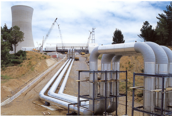
↓写真7 ブロードランツに建設中のオハーキ地熱発電所(1988年2月20日撮影)。
