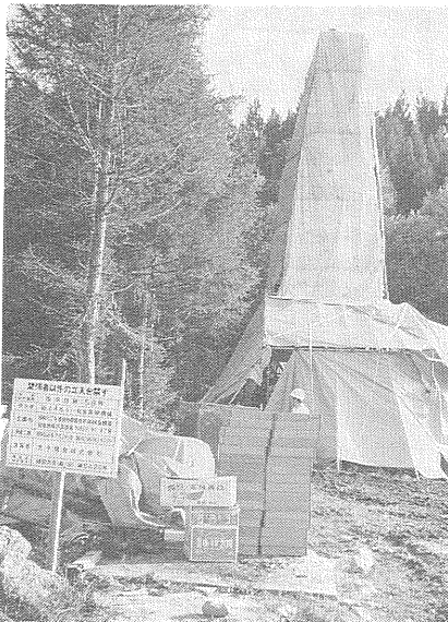
写真1 仙岩地域で掘削中の熱流量調査井 H-17 (深度 400m)
