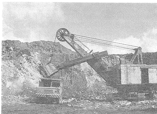
写真9 老廠鉱床のオープンピット。
