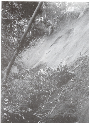
写真8 斜面崩壊 滑落崖（成東町 12月21日撮影）
