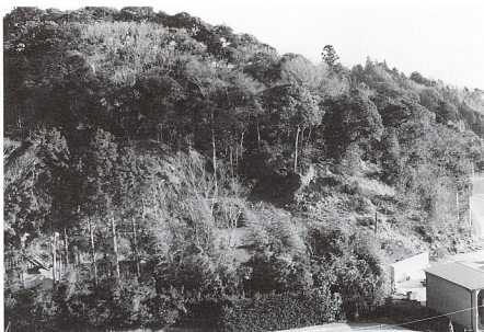
写真10 夷隅町八乙女の地すべりの全景
