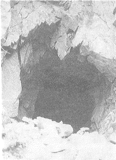
写真9 大岩旧坑（通気坑として使用）。
