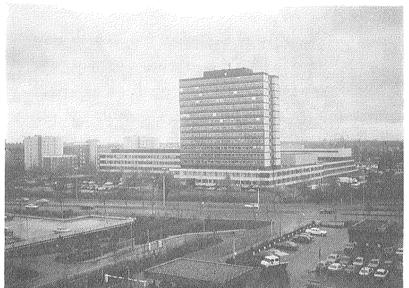
第12図 ハノーバーにおける BGR 全景 (津 宏治提供)
