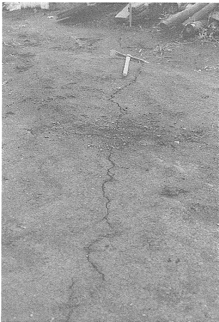
第10図 割れ目(新開) 本地点ではこの様な小地割れが数条平行して分布する。この地点の地割れは、住民の方によると数カ月たった最近でも明瞭に残っているとの事である。
