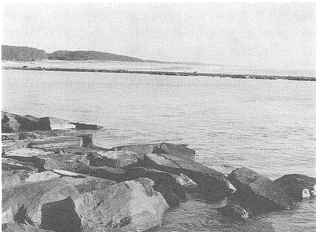
写真-2 野蒜港突堤の跡
