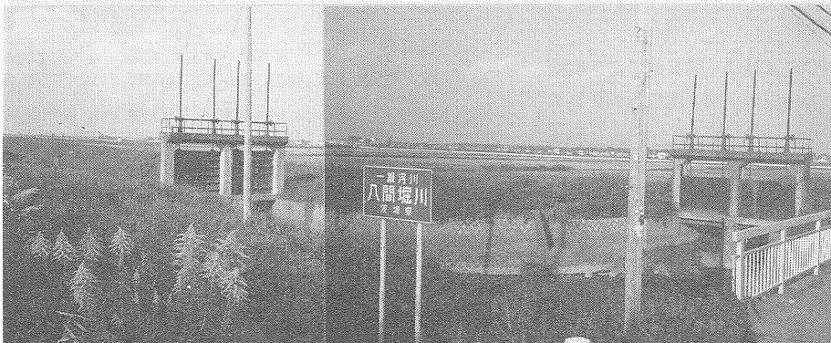
写真-14 増水した八間堀川(上)と 普段の状況(下)(石下町本豊田地先にて 1986年8月7日午後2時頃 10月15日午後4時頃 筆者撮影)。浸水流が流れ込んだ八間堀川は すぐに満杯になり 下流各所で二次的な氾濫を起きました。
