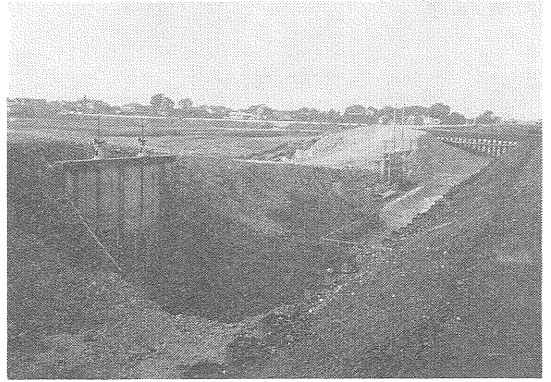
写真-13 仮堤防完成後の破堤現場(石下町本豊田にて 1986年10月15日午後3時30分頃 筆者撮影)。8月9日午前7時30分に荒締切工事(左側の石積み部分)が終了してようやく洪水流の流入を阻止しました。8月15日午後3時55分仮締切工事(右側のアスファルト固めの部分)が完了しました。
