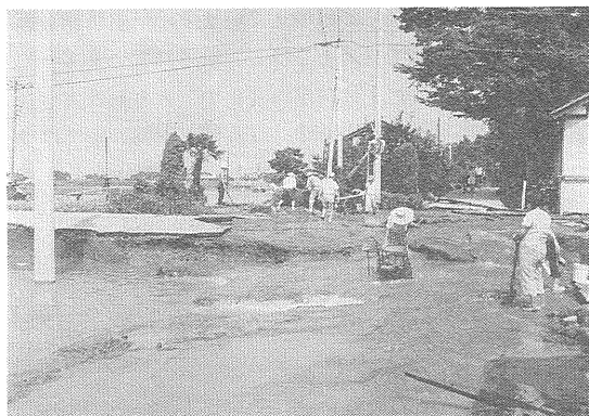
写真-11 住民の必死の水防作業(石下町本豊田にて 1986年 8月7日12時半頃 筆者撮影). 破堤地点から 直 線で250mの距離にある排水路沿いの道路は 無残 にも半分が崩落したため 付近の住民が総出で懸命 の水防作業をしています。
