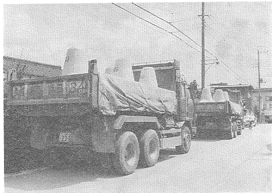
写真-9 仮締切工事用のテトラポッドを運ぶダンプトラック の列(石下町本豊田にて 1986年8月7日12時頃 筆 者撮影). 10トントラックでも わずか4個ほどし かテトラポッドを運べず しかも破堤地点までの道 路が狭いため 順番待ちのトラックの行列が長く続 きました。
