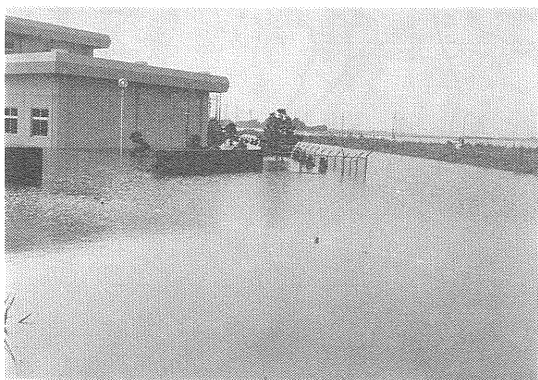
写真-17 水没した水海道市水道事務所(水海道市中山町にて 1986年8月7日午後4時頃 筆者撮影) 浸水域の最下流に位置したため 排水が完了するま での長期間上水の供給がストップしました。
