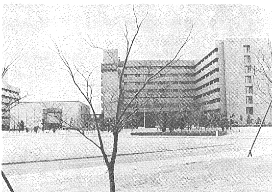
写真 左の低い建物が地質標本館で その右側に地質調査所の研究本館(8階建)がある。地質標本館の前庭には “生きている化石” のメタセコイアが植えられている。
