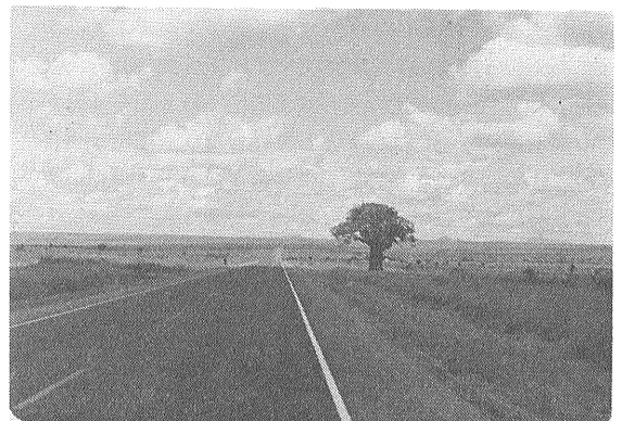
第3図 ロパツェからジワネング鉱山へのサー セレット・カマ道路 バオバブの大木が点在し 白蟻の巣が多い。
