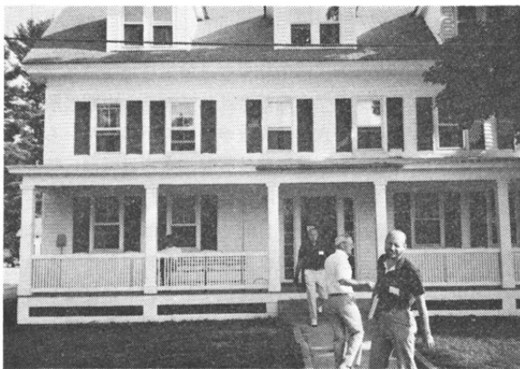
写真7 宿舎となった学生寮、屋根裏部屋を含め3階建。
