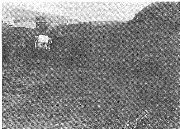
第4図 村営牧場での除灰作業。ここは噴出口に近いので、堆積物は厚さ約5mにも及ぶスコリアと火山弾からなり除「灰」というイメージではありません。1984年5月18日撮影。
