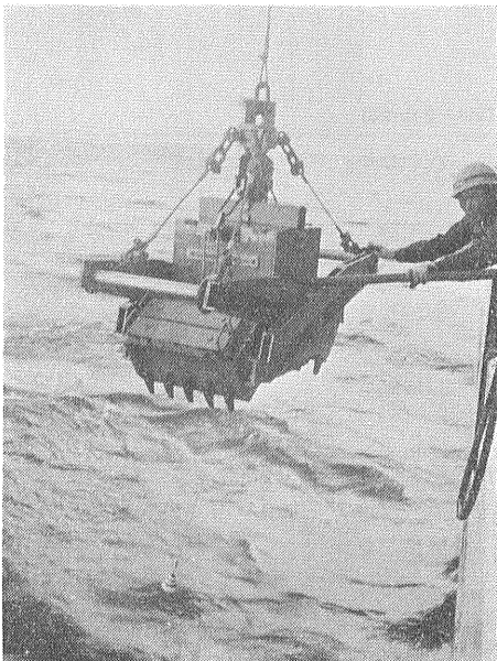
第10図 現地性岩石を採取するために製作された採岩器。
