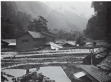
写真10 二次泥流堆積物に埋められた水ヶ瀬事業所。岩屑流の直撃を免れた水ヶ瀬事業所も、二次泥流として流れ出した岩屑に埋められた。(9月18日撮影)
