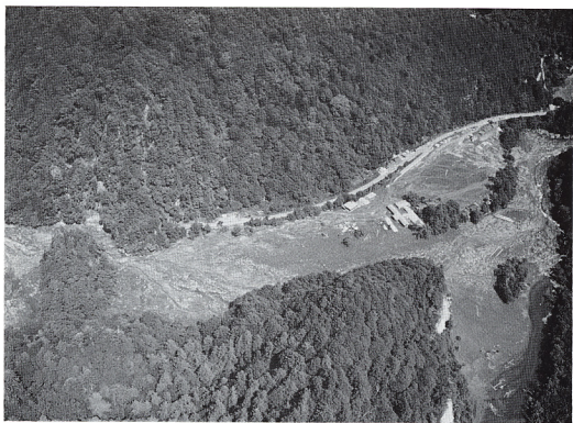
写真9 水ヶ瀬付近の岩屑流堆積物と二次泥流堆積物。写真左手の水ヶ瀬が自然の堰場となって岩屑流を食い止めた。しかし、営林署の事業所は二次泥流堆積物に埋められた。(9月21日撮影)
