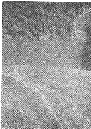
写真7 岩屑流に表土を剥ぎ取られた伝上川の側壁と屋根上にあふれ出した側流が残した堆積物の流痕。写真中央付近にヘリコプターが小さく写っている。(9月17日撮影)
