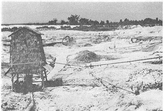
写真2-3 グラベルポンプ法による錫の採掘場。 左端は錫石を含む泥水を汲み上げるポンプ小屋
