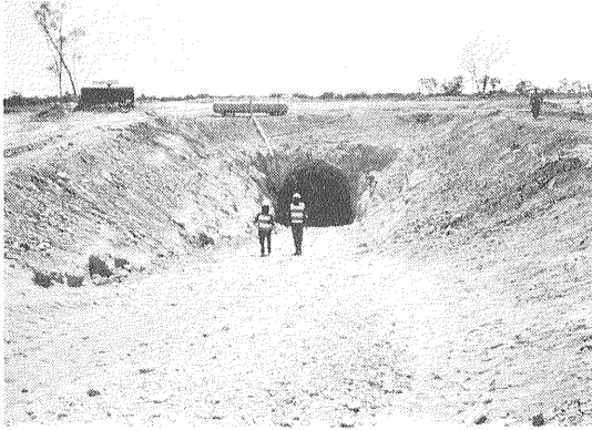
8図 1972年に発見されたニューサウスウェールズ州 Elura 鉱床の坑道入口。この地域の年間雨量は約300mm。風化帯は地下130m迄達する。
