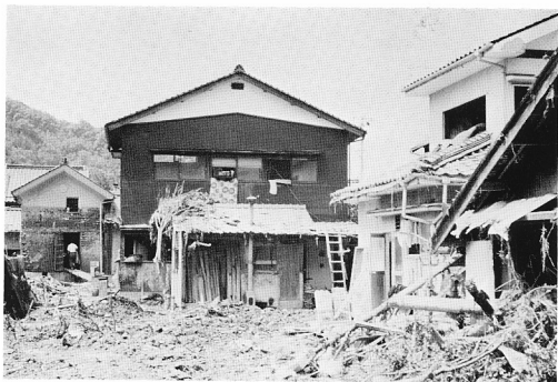
写真5 土砂・流木を含む洪水流によって壊滅的な被害をうけた三隅町中心部 土蔵の壁の線は洪水流の高さを示す
