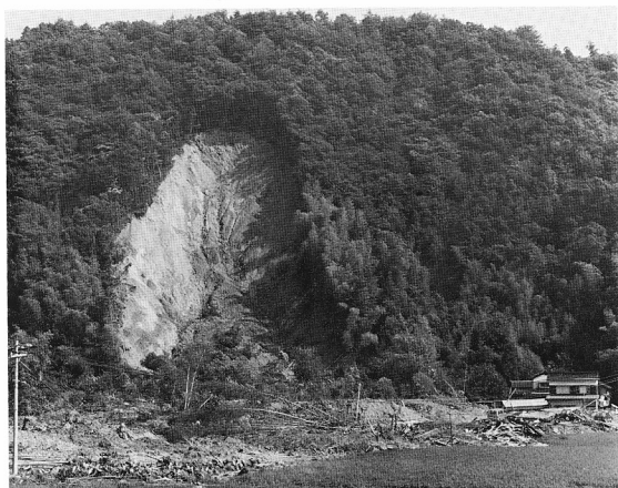
写真1 浜田市種出町中場の災害現場(15人死亡)
