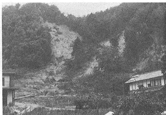
写真15 第三紀安山岩類の崩壊(益田市大谷町) 広範囲に崩壊が起り 土石流となって田・畑を埋めている
