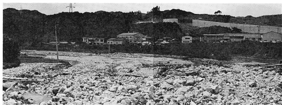
写真6 八郎川に流れ込む清水川の土石流の末端部の状況。
