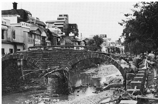
写真8 構造物の被害状況 中島川の泥害による国室・巖鏡橋の沢壊（らんかんですりの流出）。
