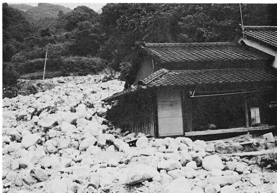
写真9 清水川の土石流によって半潰した民家（瀬古）。
