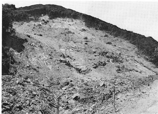
写真1 長崎市奥山における崩壊地の全景(二つの滑落崖をもつ)。
