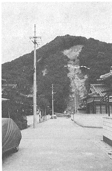
写真9 東町長竜寺の崩壊現場 破線は不整合の位置
