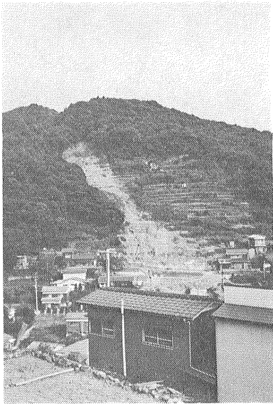
写真5 鳴滝町の崩壊現場
