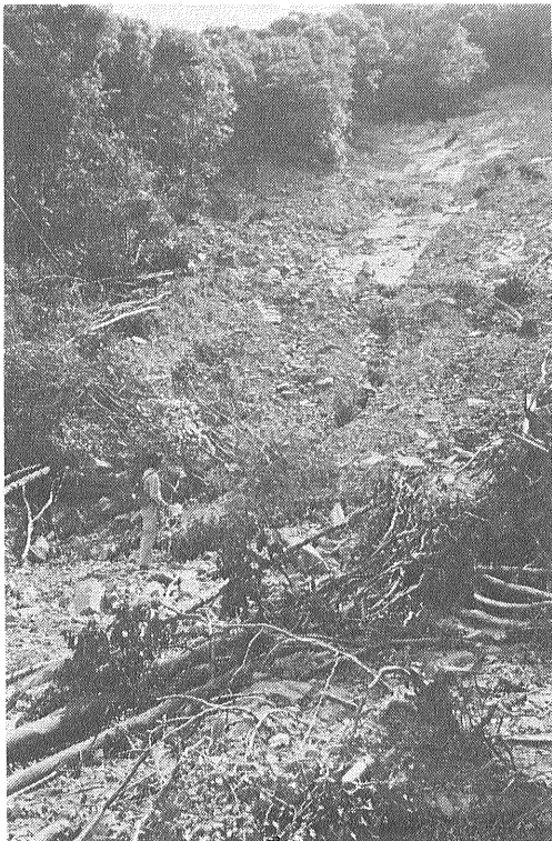
写真7 中里町中野の崩壊現場
