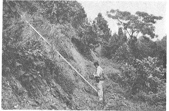
写真11 再活動した地すべりによって新たに形成された滑落崖(茂木町)
