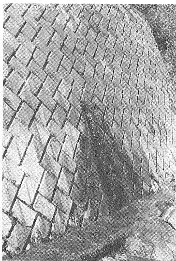
写真13 木曾温泉保養センター源泉の逸水 逸水孔の奥深くパイプを入れて採水した。
