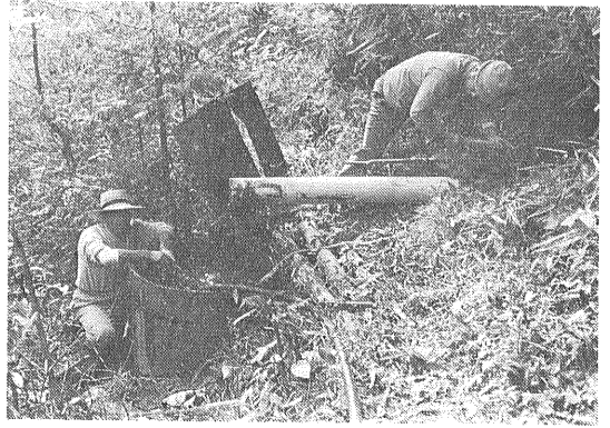
写真 21 かもしか荘源泉 (その 2) 風呂桶に溜めた鉱泉水を サイフンの原理を利用して 3.4km 引湯し 加熱利用している。風呂桶は水上置換によるガス採取にも利用できた。
