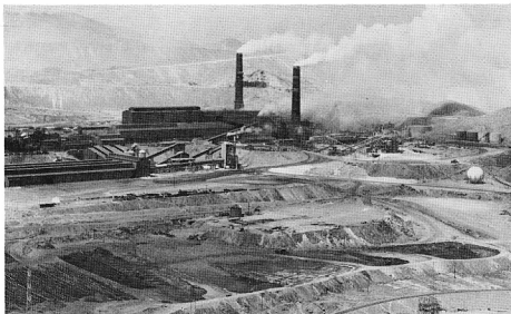
写真7 製錬所風景。鉛石は現地で銅金属にしてヨーロッパ、一部アメリカ合衆国に輸出される。製錬所からのスモッグは風が動き始める午前10時頃まではすっぽりとチュキカマタの町を覆っている。
