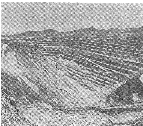
図5 チュキカマタ鉱床のピット。ピットの大きさは長さ4000m 幅1800m 深さ450mである。
