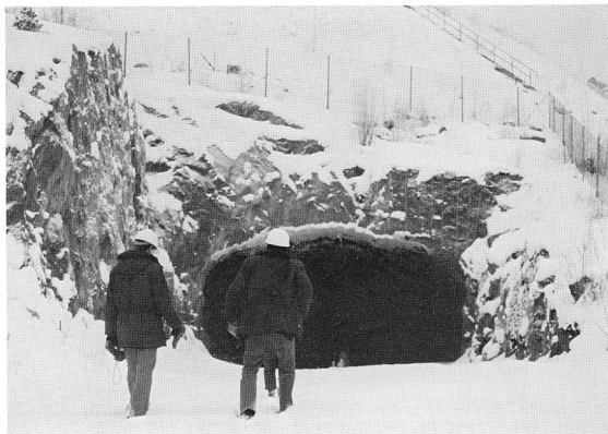
写真3 フィンランド最大の石油地下備蓄基地 ボルボ（ヘルシンキ東方）の作業用トンネル入口。 岩石は先カンブリア系花崗岩で非常に堅硬である。
