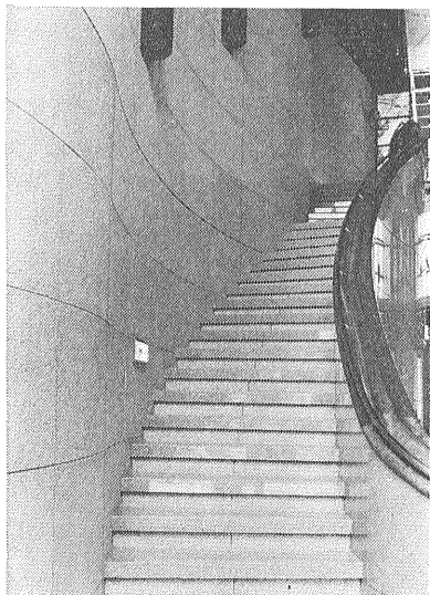
図2 1階展示ホールと2階展示室に連絡する階段。ジェットパーナー仕上げと本磨仕上げの石材でゆるやかな曲面を表現している。
