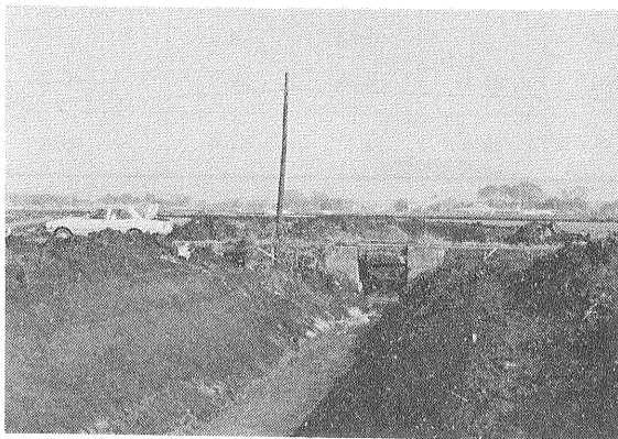
写真2 西谷田川流量観測点(上里橋) 河川改修中の状況。右岸の切り込みを見ればローム層がうすく すぐに常総粘土層が現われているのがわかる。自由地下水はこの粘土層の上部に賦存する。遠方の山は筑波山である。
