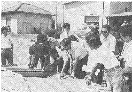
図一10 松本市水道局で大口径集水井をのぞき込む (1978)
