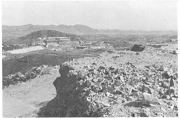
採掘ベンチから建設中の選鉱場を見る。 ベンチの高さは12m。右端の白い塔の様に見えるのはボーリングの樽。
