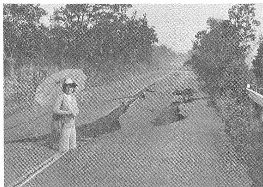
第9図 1975年11月の地震でカルデラの周囲の道路にできた割れ目。写真の右がカルデラ壁。この道路は崩落のため車両の通行が不能となった。
